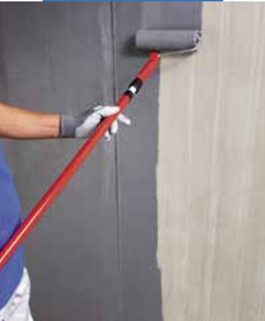
Nakładanie Eco Prim Grip Plus wałkiem na powierzchnię betonową
