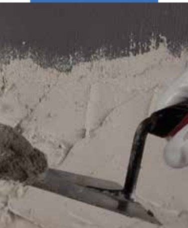
Nanoszenie tynku na Eco Prim Grip Plus
