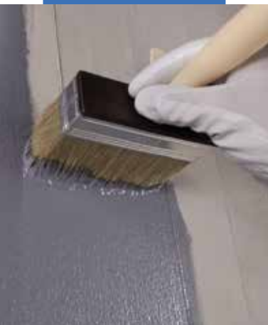
Nakładanie Eco Prim Grip Plus pędzlem na powierzchnię betonową
