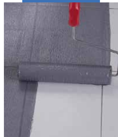
Nanoszenie Eco Prim Grip Plus wałkiem na płytki z gresu porcelanowego
