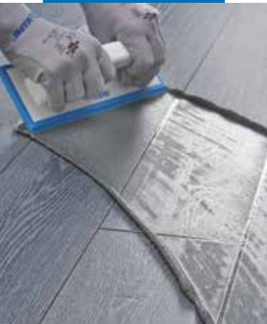
Aplikacja Ultracolor Plus za pomocą pacy gumowej na drewnopodobnej okładzinie z gresu porcelanowego
