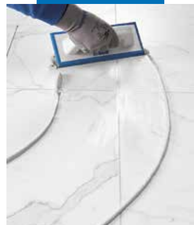
Spoinowanie płytek imitujących kamień naturalny
