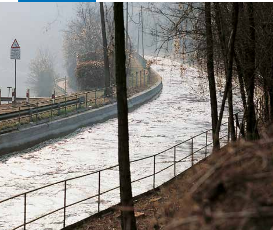
Kanał hydroelektrowni Bertini w okolicach Como, Włochy. Powierzchnie pokryte Planiseal 88
