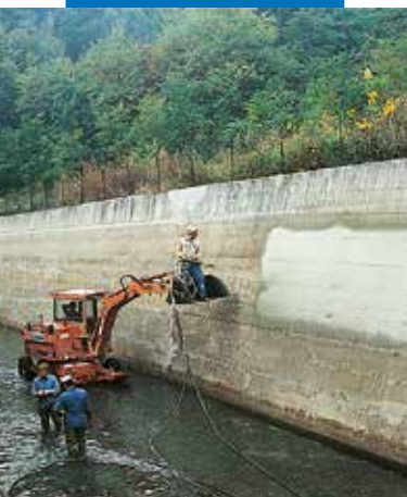
Aplikacja Planiseal 88 metodą natrysku w kanale hydroelektrowni
