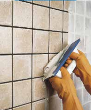
Spoinowanie płytek glazurowanych
