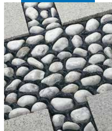
Spoinowanie dekoracyjnej posadzki kamiennej
