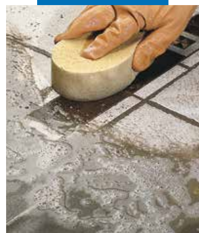
Profilowanie posadzki ceramicznej z elementami drewnianymi przy użyciu gąbki
