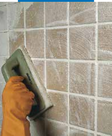
Wstępne zmywanie i profilowanie spoiny przy użyciu pacy Scotch-Brite®
