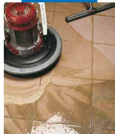
Czyszczenie podłogi z gresu porcelanowego przy użyciu maszyny czyszczącej i rakli
